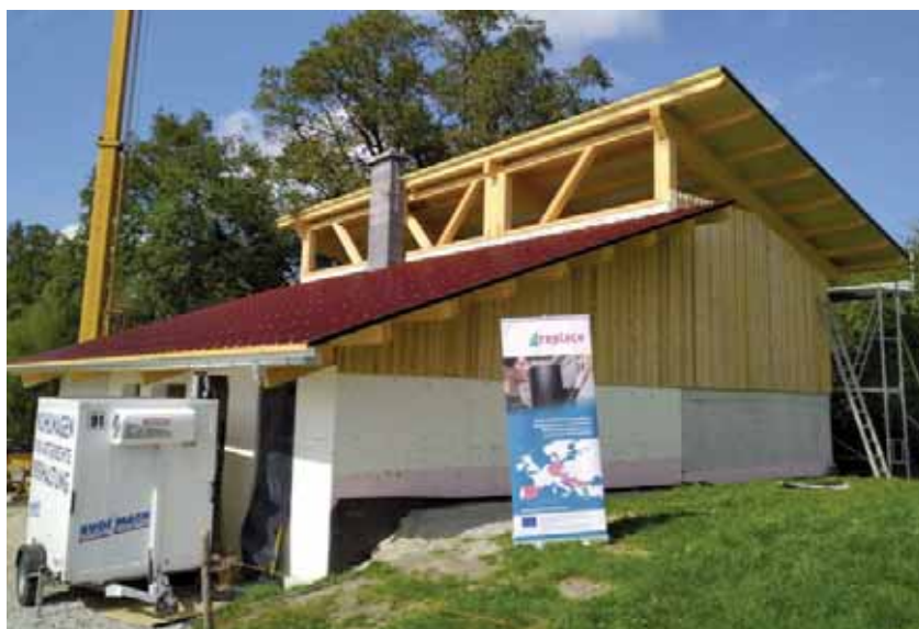
Beispiel: Gebäude Heizhaus Oberhausen Lkr. Weilheim-Schongau
