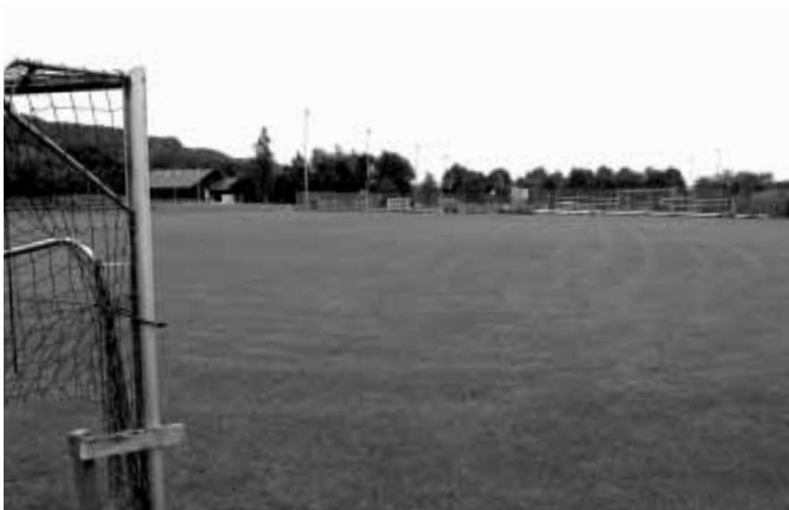
Blick von Südosten auf den sanierten Rasen-Sportplatz. Die eingebaute Bewässerungsanlage hat sich im Juni bereits gut bewährt!
